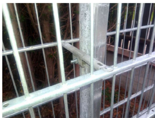
fot. 4 Mocowanie gabionu do słupka stabilizującego – zdjęcie poglądowe.
