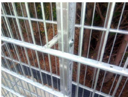
fot. 4 Mocowanie gabionu do słupka stabilizującego – zdjęcie poglądowe.
