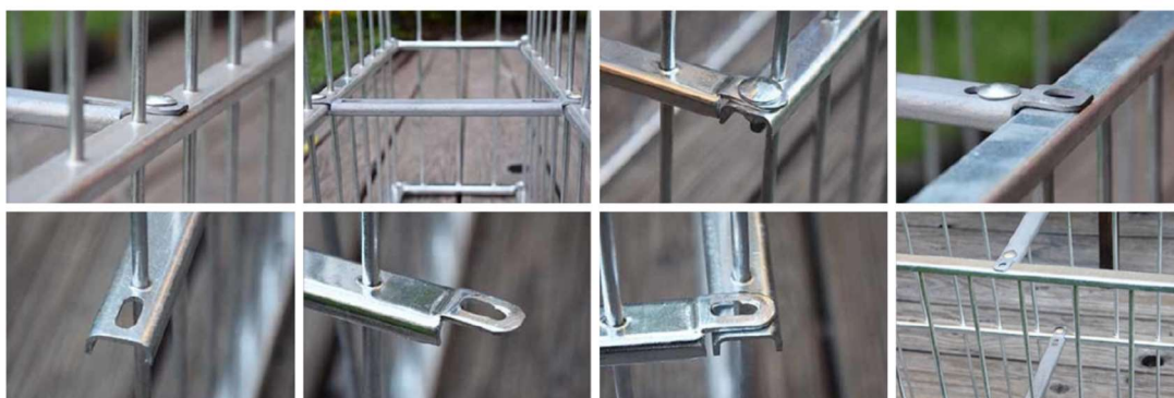
fot. 3 Przykładowy montaż łączników kosza gabionowego.
